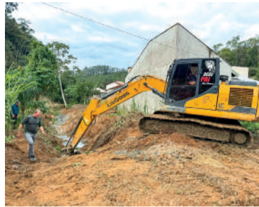
LIMPEZA de córregos busca prevenir alagamentos
