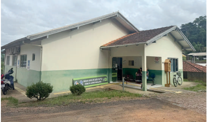
SERVIDORA notou sinais de arrombamento
