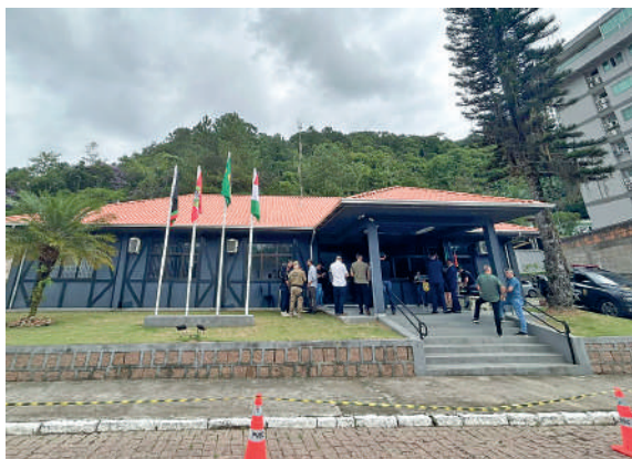
ALÉM da reforma no telhado, prédio deverá receber pintura
