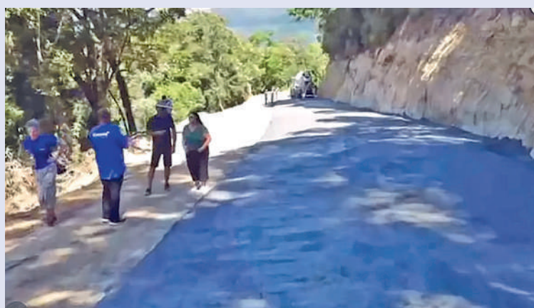
SERRA do Caminho do Morro recebeu concretagem
