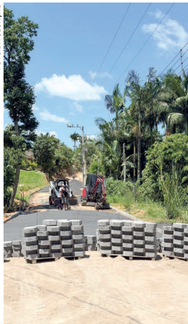
SETOR realiza fiscalização de obras
