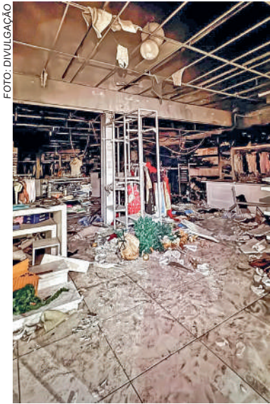
INCÊNDIO destruiu parte de estrutura
