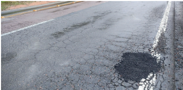
TRECHO recebeu obras paliativas
