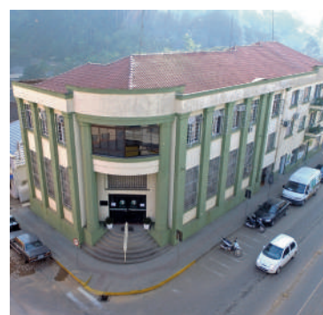
PRÉDIO passa por reformas
