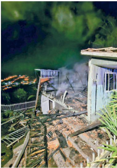
CASA foi totalmente destruída
