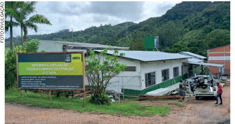
OBRAS incluem troca do telhado
