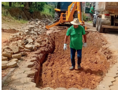
OBRAS intensificou diversos serviços
