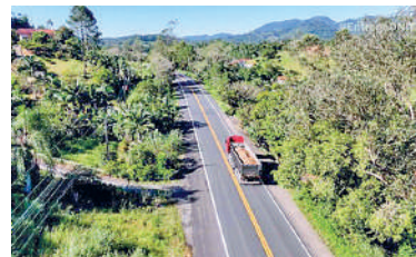
INICIATIVA CONTEMPLA um dos segmentos mais críticos da rodovia, a travessia urbana de Rio do Sul
