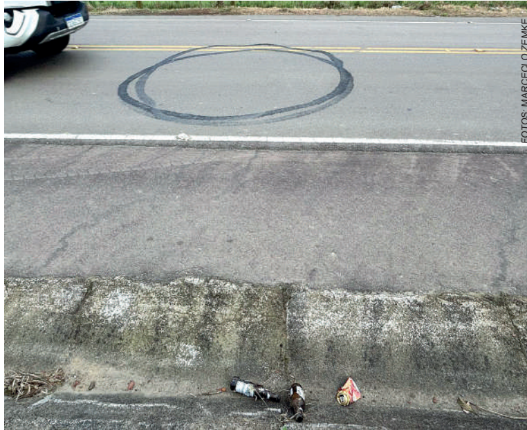
LIXO deixado por frequentadores e marcas de pneus estão ao longo da rodovia
