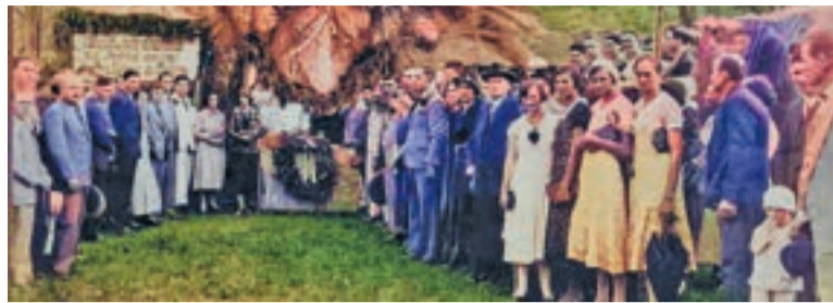
LANÇAMENTO da Pedra Fundamental ocorreu no Distrito de Dalbérgia
